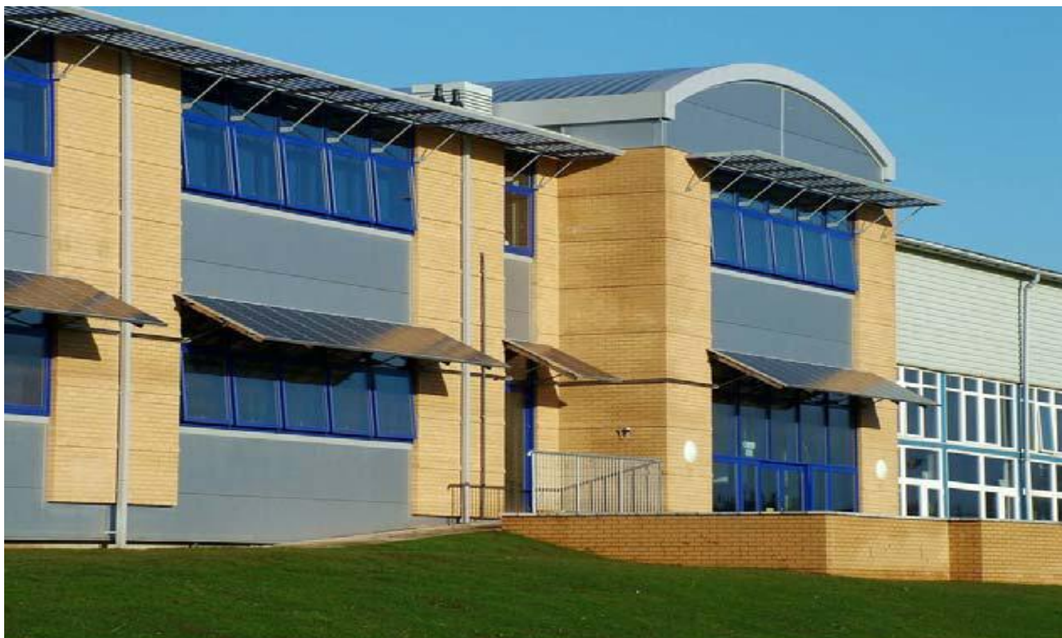
Fig.17 – Esempio di installazione idonea alla classificazione dell’impianto fotovoltaico nella categoria “su edifici”
